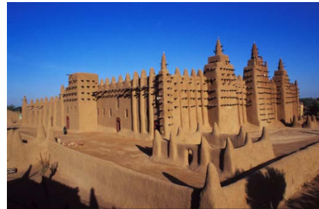
Figure 1: Construction en terre crue (crédit : Ecole Nationale Supérieure d'Architecture de Grenoble -
