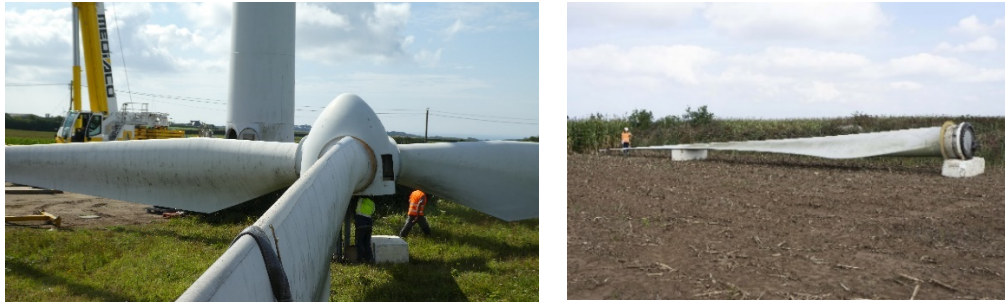
Figure 28 : Démantèlement du parc éolien de Plouarzel I en septembre 2021 (crédit : IPC).
