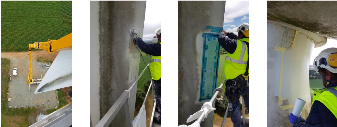
Figure 26 : Illustration d'une opération de réparation de pale d'éolienne (crédit : Alain Guilloteau).
